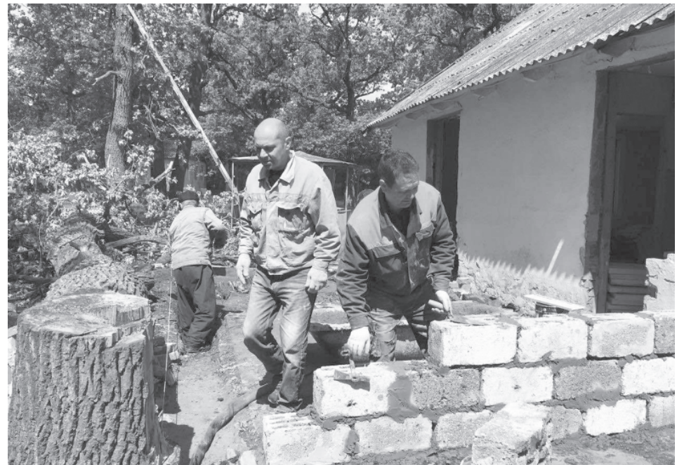
В “Дубраве” полным ходом идет реконструкция дачи № 3
